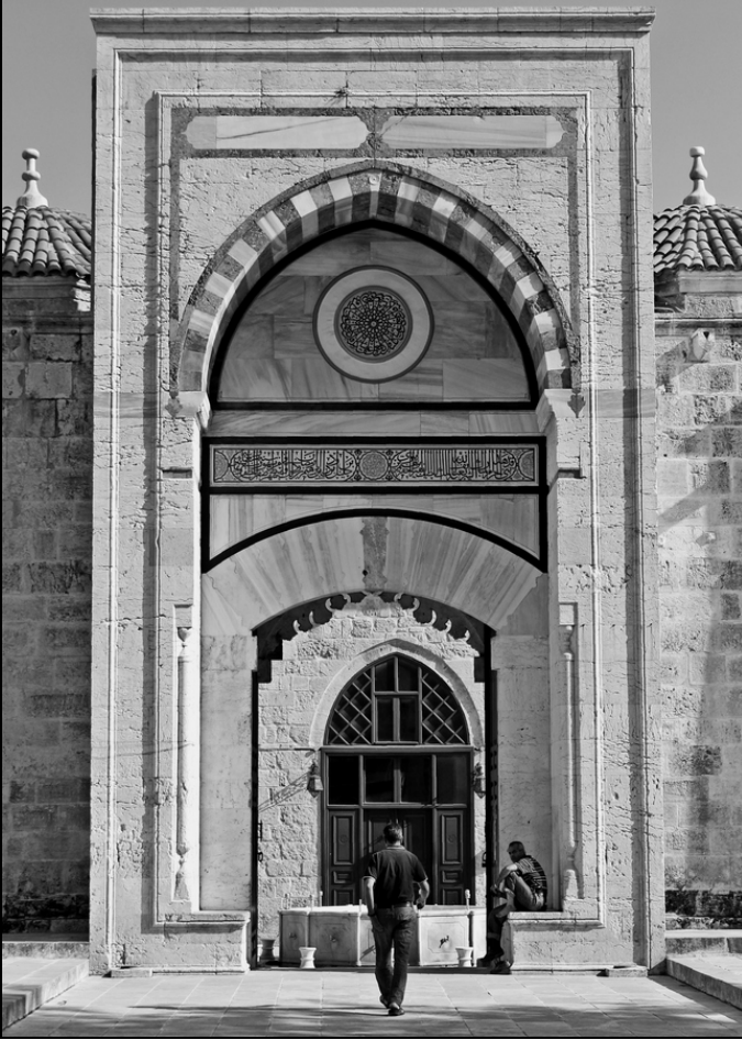
Ulu Camiî Giriş Kapısı
